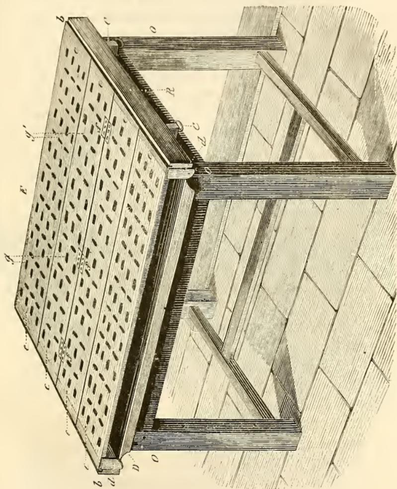
FIG. 10. — Table à vivisection. — Ici la table à vivisection n'est pas repliée en gouttières (voy. ci-après fig. 45, 46, 47, 18 et 19), mais simplement établie en table plane : *g, g*, trous de la table ; *e, e, e*, ses panneaux ; *f, f*, charnières de ces panneaux ; *o, o*, pieds de la table proprement dite, avec son liteau *D* et ses rebords mobiles *R*, que maintiennent les tasseaux *C, C*.
